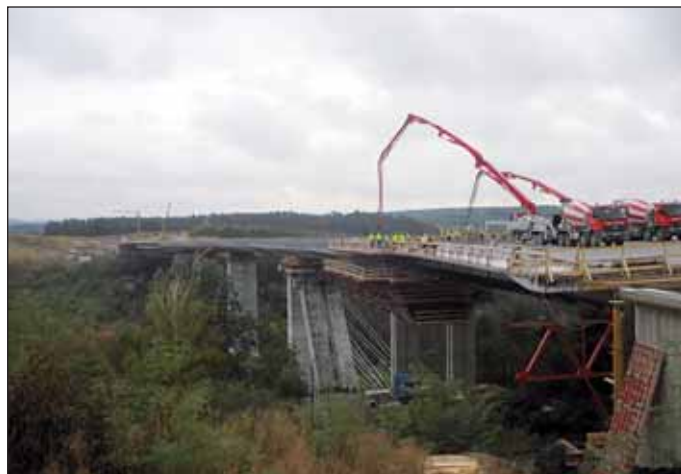
Obr. 4 Betonáž mostu přes Lochkovské údolí (st. 514) Fig. 4 Casting of the bridge over the Lochkov valley (lot 514)
