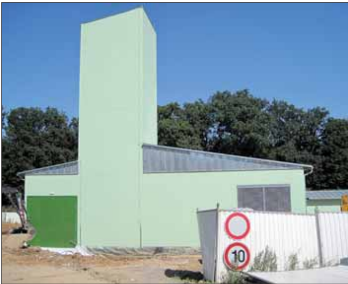
Obr. 14 Nadzemní část vzduchotechnického objektu Fig. 14 Above ground part of the ventilation structure
