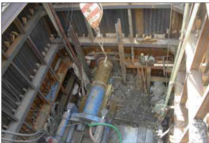
Obr. 7 SO 09 Tlačná stanice protlaku – HOBAS DN 300 (foto Ing. Alois Kvěťák)
