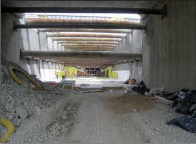
Obr. 2 Rozepřená stavební jáma tunelu I, v pozadí zárodek ražené části Fig. 2 The braced construction trench for Tunnel I with a germ of the mined part in the rear
