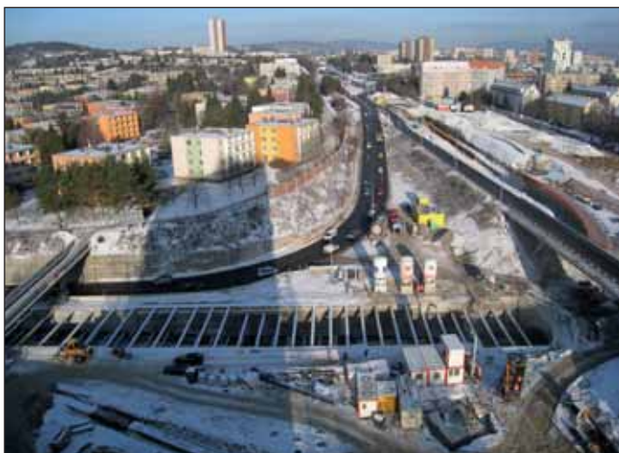
Obr. 1 Stavební jáma tunelu I pohledem z přilehlého objektu na ul. Voroněžská
