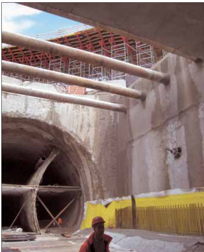
Obr. 7 Zárodek ražené části tunelu I, v pozadí nad jámou bednění mostu na větví H5 Fig. 7 The germ of the mined part of Tunnel I with formwork for H5 bridge in the rear, above the trench
