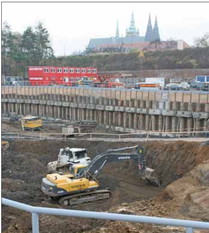
Obr. 4 Staveniště Prašný most, stavební jáma pod barokními hradbami Fig. 4 Prašný Most construction site: construction trench under Baroque fortification
