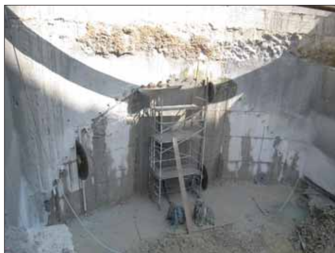
Obr. 6 Prořezávání otvoru pro zárodek tunelu I v podzemní stěně provizorního portálu Fig. 6 Cutting an opening through a diaphragm wall of the temporary portal for the germ of Tunnel I
