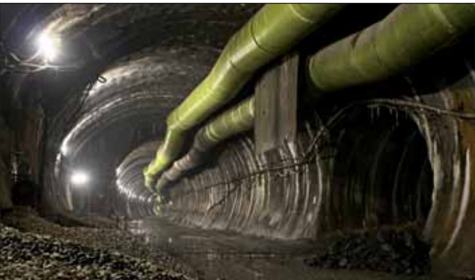
Obr. 8 Ražený tunel Královská obora, vyražený tunel v místě zářivu a napojení propojky Fig. 8 The Královská obora mined tunnel: complete tunnel excavation in the location of the lay-by and cross passage connection
