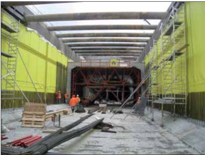
Obr. 8 Bednicí vůz Fig. 8 Travelling shutter
