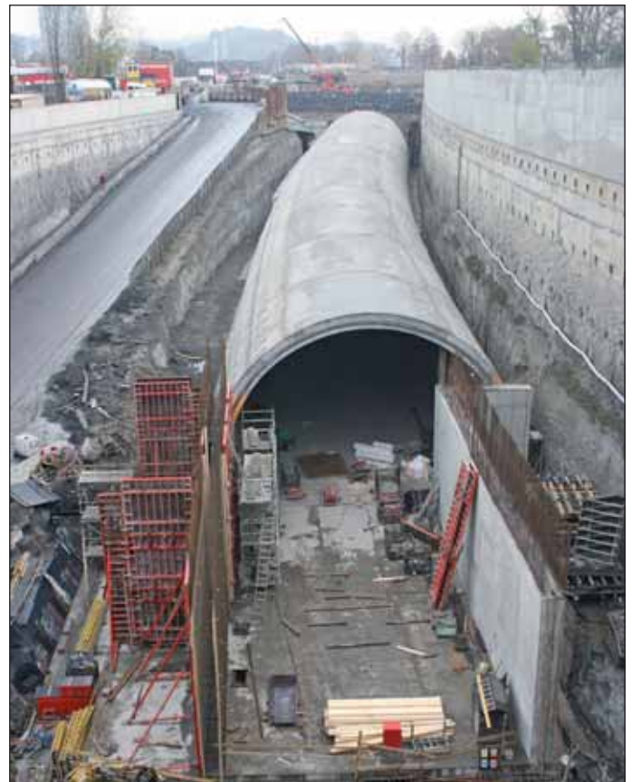
Obr. 11 Staveniště Troja, výstavba jihovýchodní čtvrtiny technologického centra Fig. 11 Troja construction site: construction of the south-eastern quarter of the service centre
