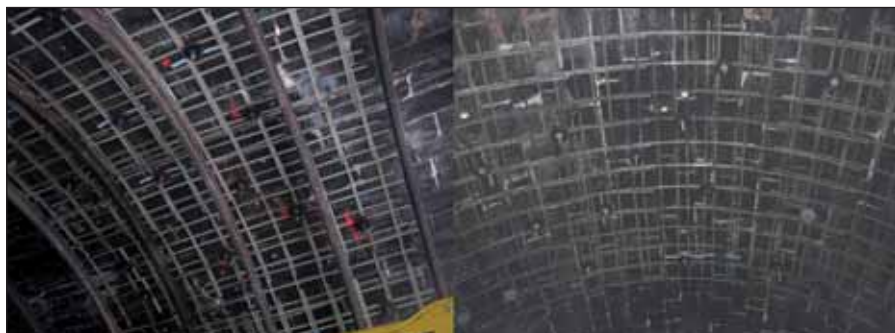
Obr. 6 Bohuslavický tunel – výsledek sanace
