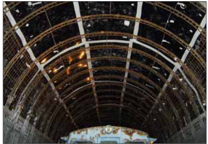
Obr. 3 Harrachovský tunel – realizace
