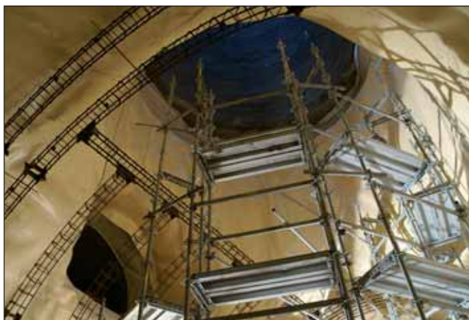
Obr. 10 Hydroizolace v místě podzemního rozpletu Fig. 10 Waterproofing in the underground node location
