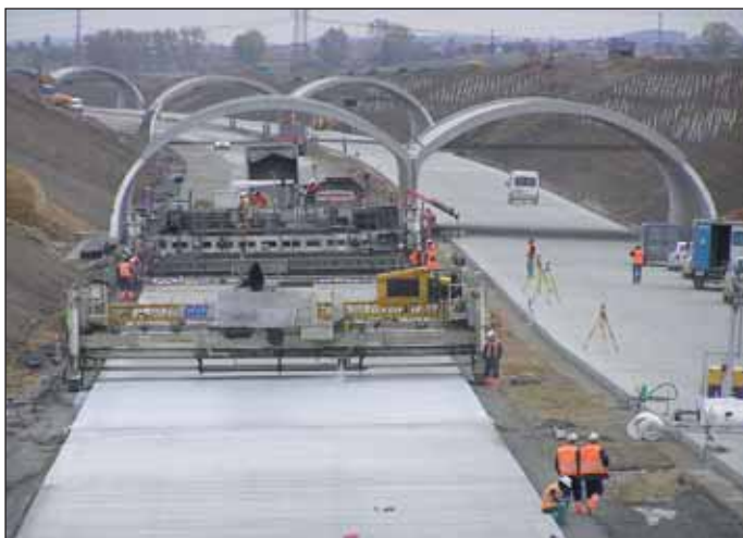
Obr. 5 Pohled na trasu od cholupického portálu, v pozadí oblouky budoucích biokoridorů (st. 513) Fig. 5 View of the route from the Cholupice portal; vaults of future ecological corridors in the background (lot 513)
