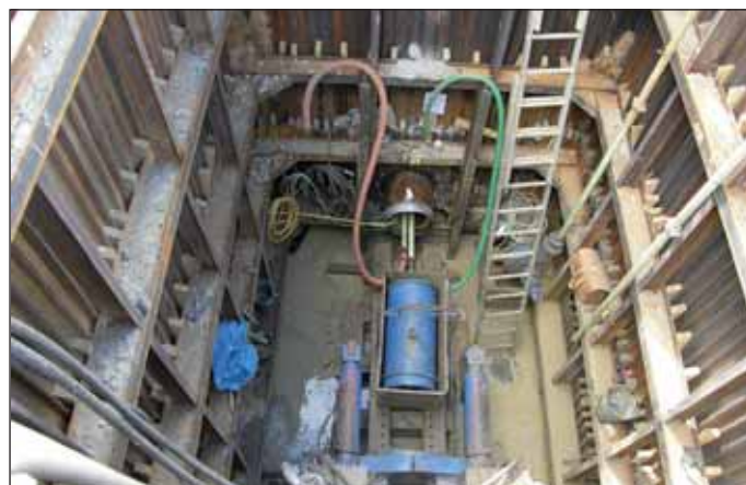
Obr. 8 SO 10 Tlačná stanice protlaku – Kamenina DN 400 (foto Ing. Alois Kvěťák) Fig. 8 SO 10 Thrust-jacking station – DN 400 stoneware pipes (Photo courtesy Ing. Alois Kvěťák)
