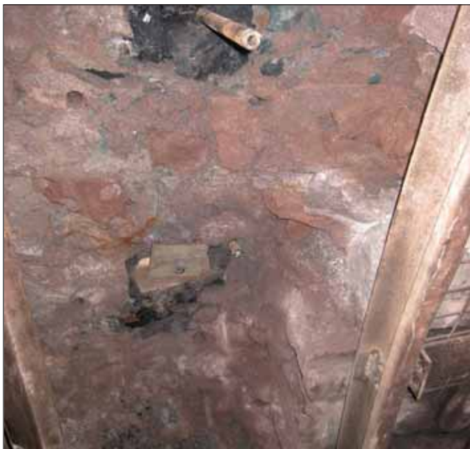
Obr. 9 Banskoštiavnický tunel – realizace (bourání ostění, zkracování kotev) Fig. 9 Banská Štiavnica tunnel – rehabilitation works (breaking off the lining, cutting the length of anchors)
