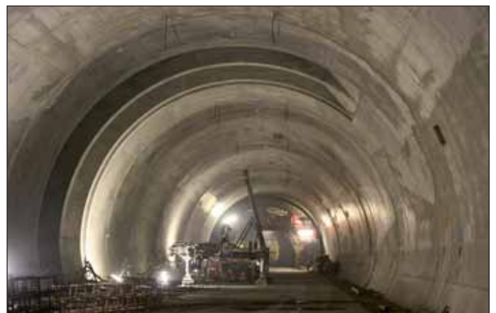
Obr. 9 Ražený tunel Královská obora, dokončené definitivní ostění Fig. 9 The Královská obora mined tunnel: complete final lining
