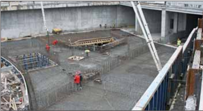
Obr. 1 Staveniště Malovanka, betonáž spodní desky portálové dilatace Fig. 1 Malovanka construction site: casting of the bottom slab of the portal block
