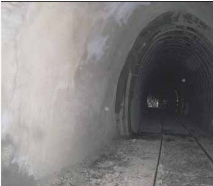
Obr. 11 Banskštiavnický tunel – dokončený úsek sanace Fig. 11 Banska Štiavnica tunnel – finished part of the refurbishment
