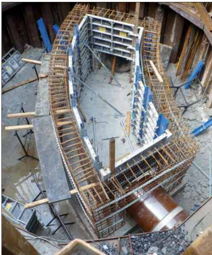
Obr. 5 SO 06 Armování definitivní konstrukce SŠ 3 (foto Ing. Petr Szotkowski)
