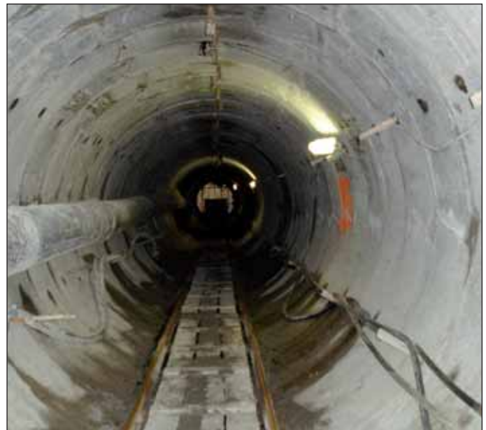
Obr. 6 SO 08 Pohled do vyraženého kanalizačního sběrače „C“ pomocí štítu ING (foto Ing. Adam Lubojacký)
