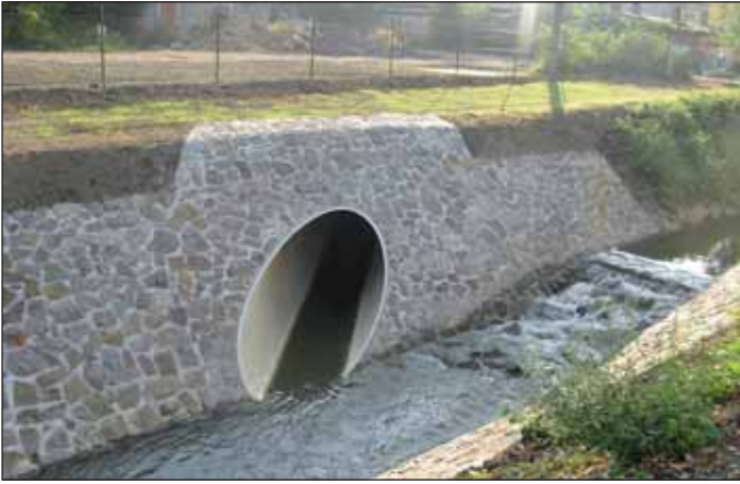
Obr. 2 SO 01 Sanace břehu karvinského potoka (foto Ing. Petr Szotkowski) Fig. 2 SO 01 The Karviná brook bank regulation (Photo courtesy of Ing. Petr Szotkowski)
