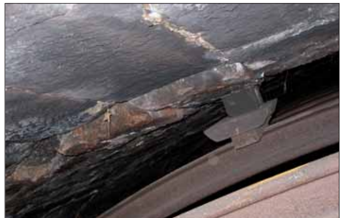
Obr. 4 Bohuslavický tunel – výchozí stav
