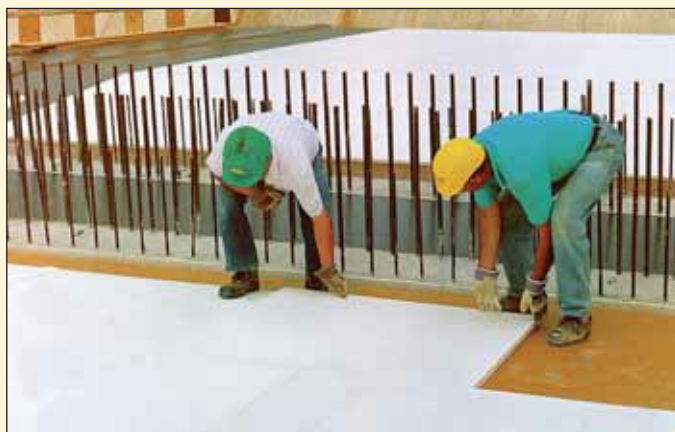
Obr. 4 Pokládání protipožárních desek PROMATECT® – T do bednění Fig. 4 Placement of PROMATECT® – T fire-protection plates into the formwork
