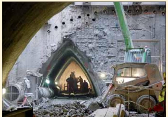
Obr. 2 Ražba tunelu – průchod přes jámu technologického centra (Foto: Pechman)
