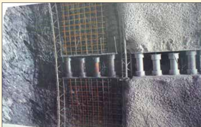
Obr. 2 Pohled na deformační elementy osazené do primárního ostění Fig. 2 View of yielding elements installed in the primary lining
