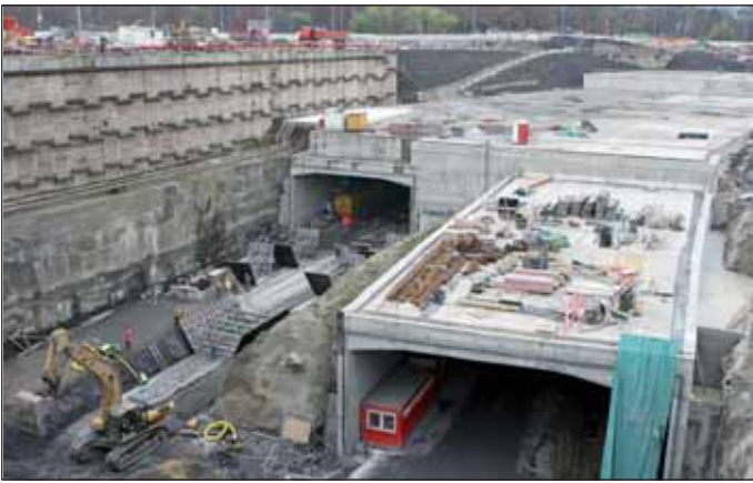
Obr. 6 Staveniště Letná, výstavba dilatace D20 v jižním tunelu (vlevo) Fig. 6 Letná construction site: construction of D20 expansion block of the southern tunnel tube (left)
