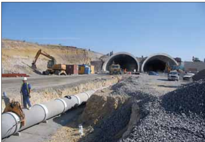
Obr. 3 Stavba dešťové kanalizace před lochkovským portálem (st. 514) Fig. 3 Construction of storm-water drainage in front of the Lochkov portal (lot 514)
