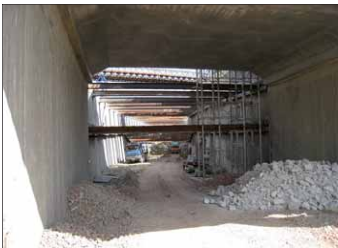
Obr. 5 Stavební jáma tunelu II, pohled od definitivního portálu Fig. 5 Construction trench for Tunnel II – viewed from the final portal
