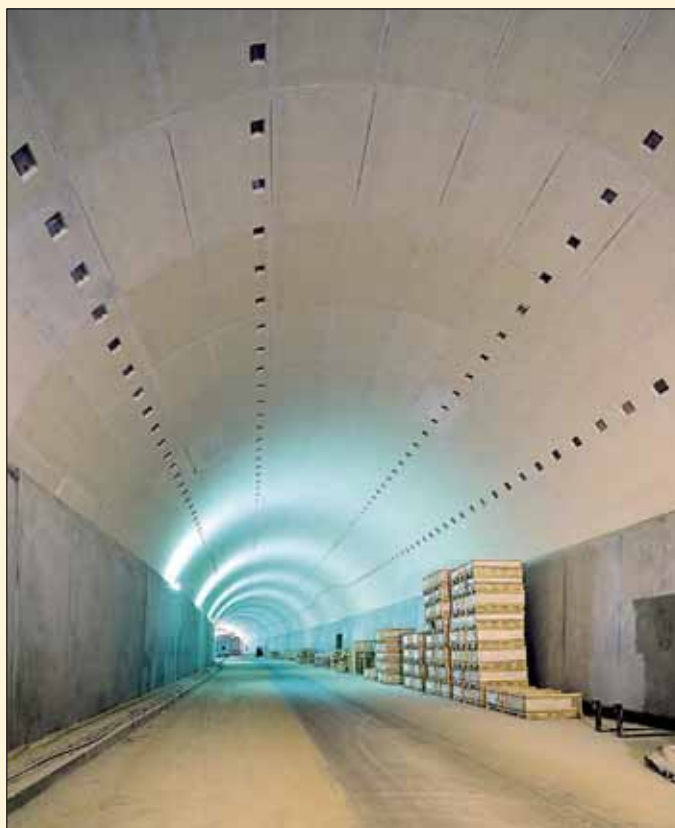
Obr. 6 Tunel s provedeným protipožárním obkladem z desek PROMATECT® – T Fig. 6 Tunnel with complete fire-protection cladding using PROMATECT® – T plates
