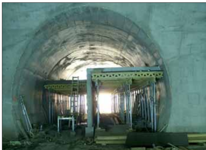
Obr. 7 Betonáž mezistropu v propojce č. 5
