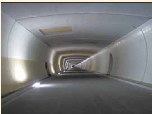
Obr. 5 Definitivní ostění a mezistrop druhé tunelové trouby Fig. 5 Final lining and intermediate deck in the second tunnel tube
