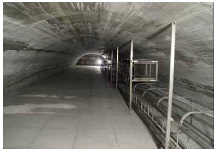
Obr. 13 Lezné oddělení ve vzduchotechnické šachtě v části pro přívod vzduchu Fig. 13 Ladder compartment in the ventilation shaft – the air supply part
