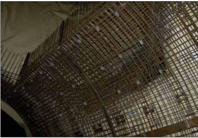
Obr. 12 Vyztužení prutovou výztuží v místě průniku šachty a propojky č. 5 Fig. 12 Reinforcement at the shaft intersection with the cross passage No. 5 using reinforcing bars
