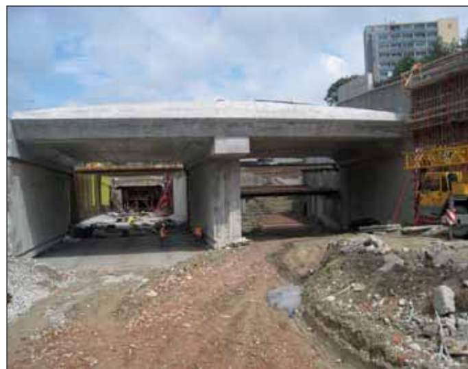
Obr. 12 Definitivní portál tunelu, nad stropní deskou je již zhotovena část galerie Fig. 12 Definite tunnel portal with a part of the gallery above the roof deck complete
