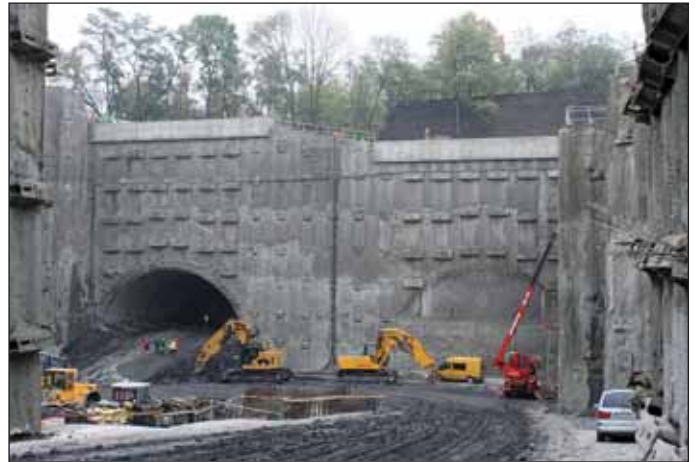
Obr. 2 Staveniště Myslbekova, portálová stěna ražených tunelů Fig. 2 Myslbekova construction site: portal wall of mined tunnels
