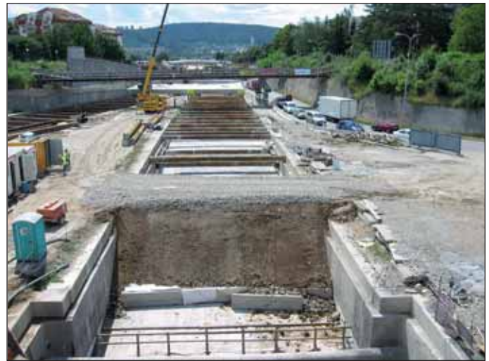
Obr. 9 Pohled shora na tunel I, vlevo tunel II, v pozadí stropní deska definitivního portálu Fig. 9 View of Tunnel I; Tunnel II on the left side, the definite portal roof deck in the rear
