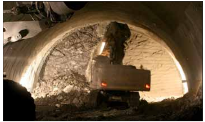
Obr. 7 Ražený tunel Královská obora, ražba tunelu Fig. 7 The Královská obora mined tunnel: tunnel excavation
