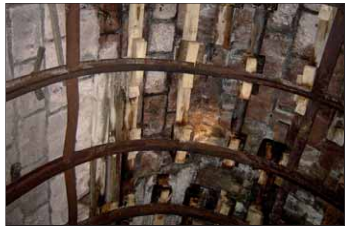
Obr. 7 Banskoštiavnický tunel – výchozí stav
