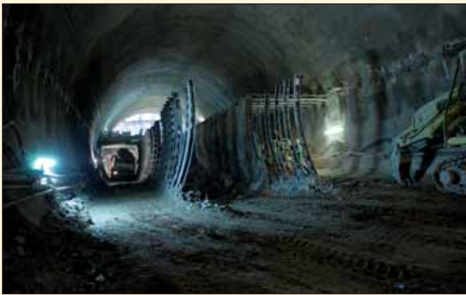
Obr. 3 Ražba tunelu – bourání vnitřních výztužných žebér (Foto: Pechman) Fig. 3 Tunnel excavation – breaking out of inner support frames (Photo courtesy of Pechman)
