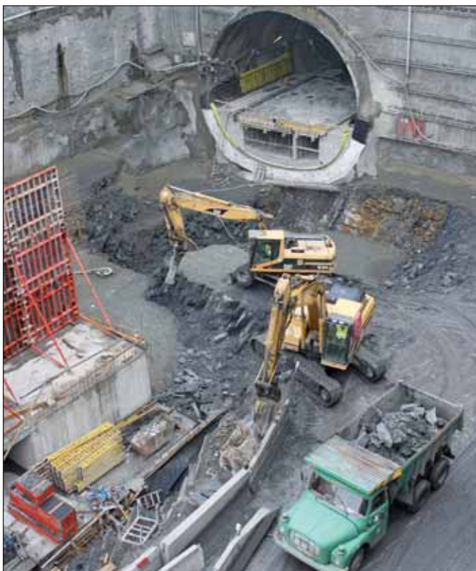
Obr. 10 Staveniště Troja, zemní práce v prostoru jihozápadní čtvrtiny technologického centra Fig. 10 Troja construction site: earth-mowing operations in the area of the south-western quarter of the service centre
