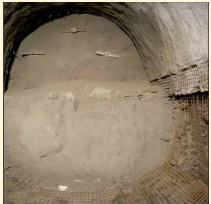
Obr. 5 Pohled na čelbu a uzavírání počvy Fig. 5 View of the heading and closing of the invert
