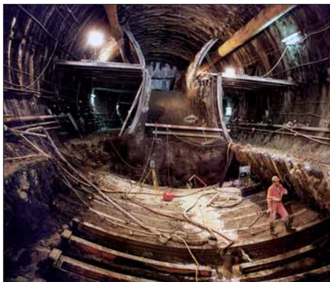
Obr. 6 Sekvenční metoda pro všechny ražby v měkkých horninách Fig. 6 Core method for all soft ground heading
