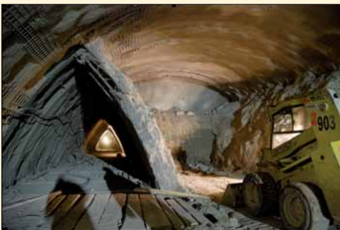
Obr. 1 Ražba tunelu – členění čelby (Foto: Pechman)
