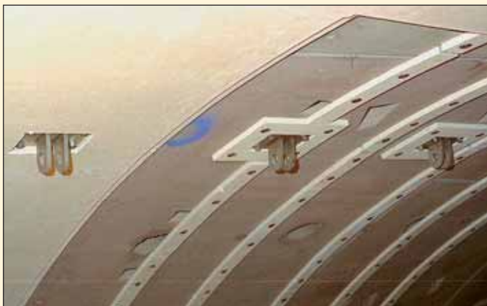
Obr. 5 Detail montáže desek PROMATECT® – T na hotové sekundární tunelové ostění Fig. 5 Detail of installation of PROMATECT® – T plates on a completed secondary tunnel lining
