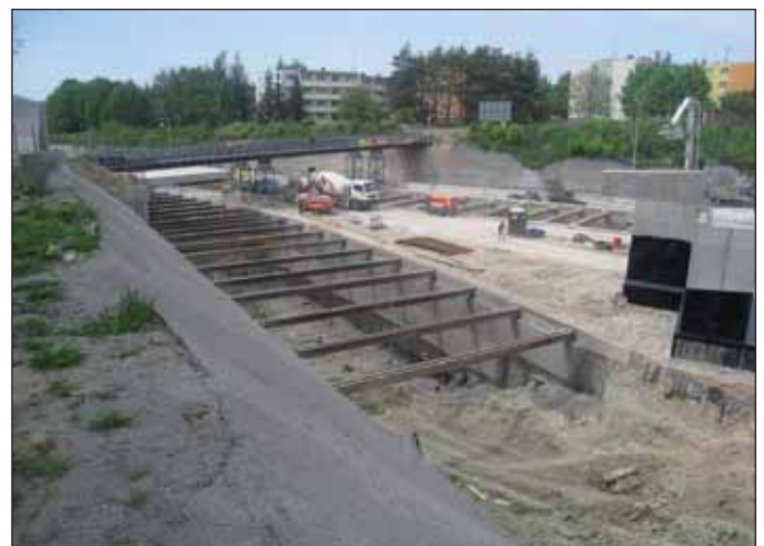
Obr. 4 Stavební jáma tunelu II, pohled shora Fig. 4 Construction trench for Tunnel II
