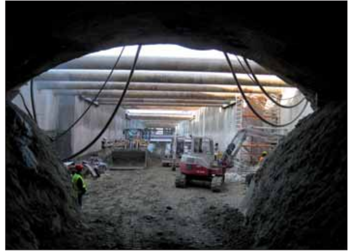
Obr. 3 Pohled do stavební jámy tunelu I ze zárodku ražené části Fig. 3 View down the construction trench for Tunnel I from the germ of the mined part
